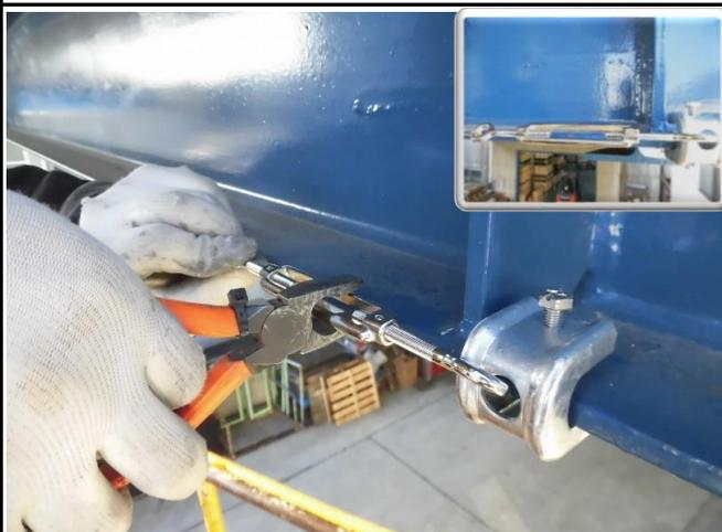
⑨ターンバックルにてワイヤーを締め込む
