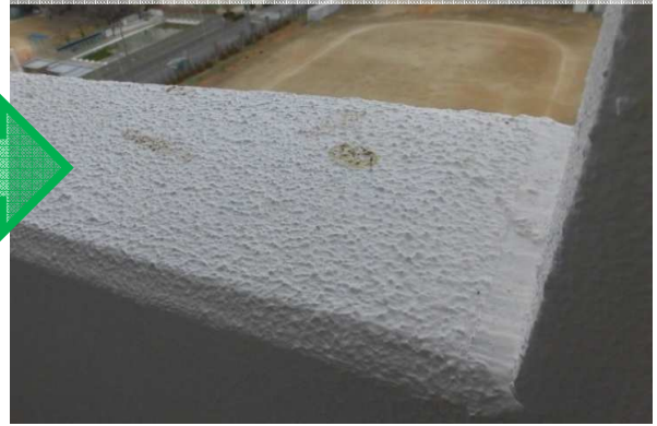
施工前に撤去しておきます
