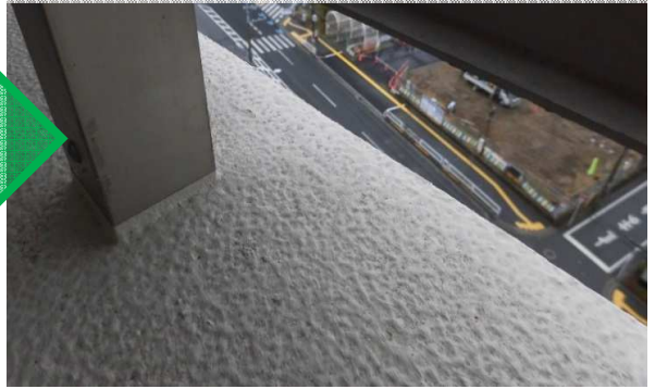
施工前に拭取り、乾燥させます
