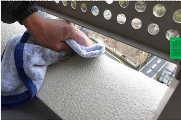
固定具設置箇所の水気や油分(雨など)
