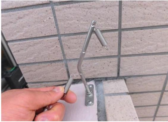
⑤支柱反対側に引張バネを取り付ける
